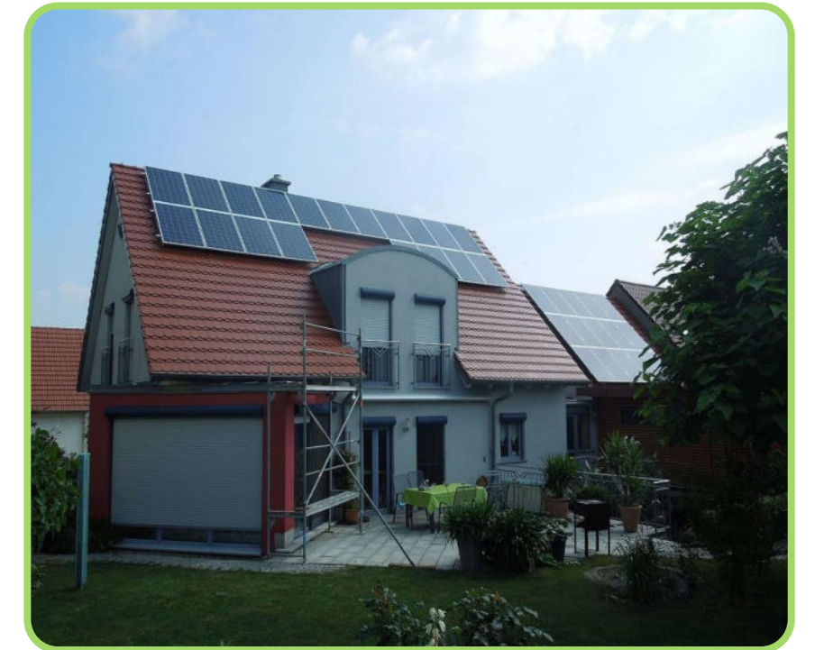
Solarförderung In Osnabrück durch das Programm „Photovoltaik-Plus“, Einfamilienhaus mit PV-Anlage Quelle: Wikimedia Commons
